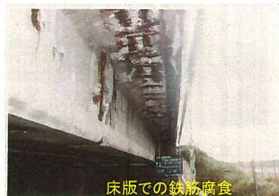
PC桁での鉄筋腐食
