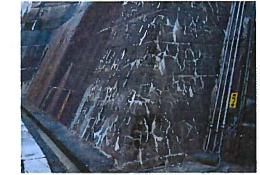
方向性のない亀甲状のひび割れが発生
