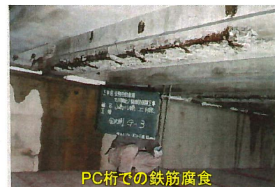
PC桁での鉄筋腐食
